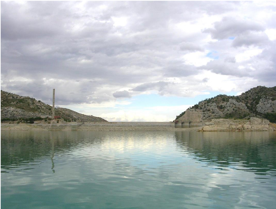
Figura 7. Vista de la presa del embalse
