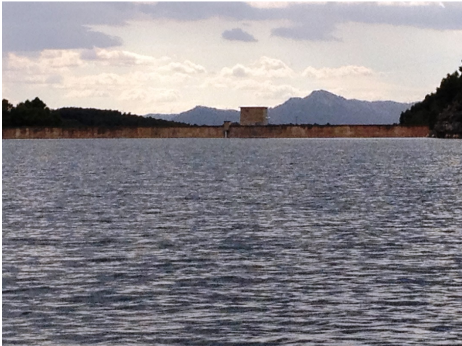
Figura 7. Vista de la presa del embalse
