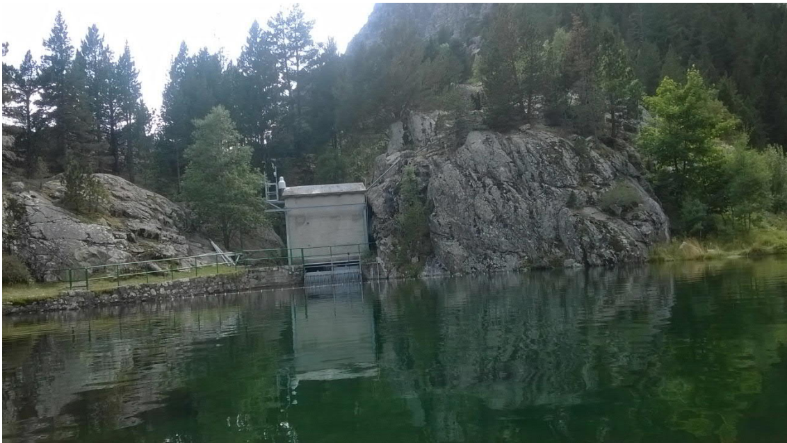
Infraestructuras artificiales en la cubeta
