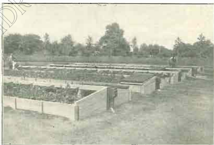
CAJONERAS TERMOLÉCTRICAS SIEMENS
