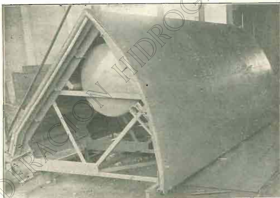
Alza automática de sector metálico, de 8 metros ancho y 2'50 metros altura, para la instalación de Gavet, de la Compañía "Riegos y Fuerza del Ebro"
